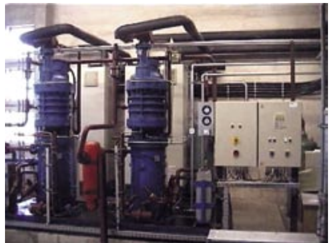
VARISCREW+ im Einsatz VARISCREW+ in operation
